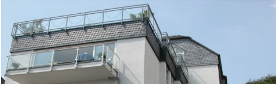
Frontalansicht auf das Gebäude
